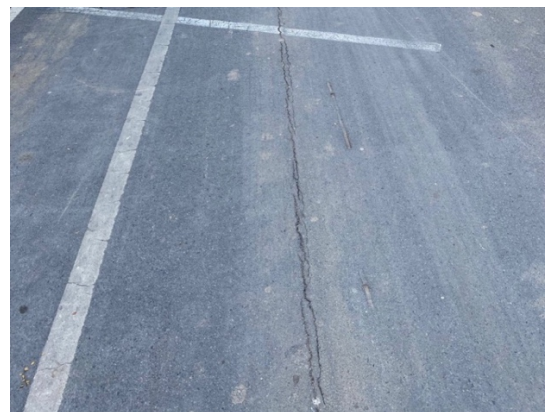
รูปที่ 2.3 ความเสียหายประเภทรอยแตกตามยาว (บริเวณข้างสำนักพิมพ์จุฬา)
