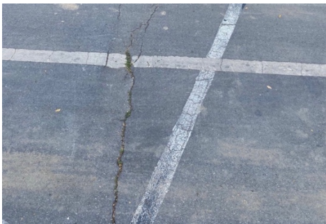
รูปที่ 2.4 ความเสียหายประเภทรอยแตกตามขวาง (บริเวณข้างสำนักพิมพ์จุฬาฯ)
