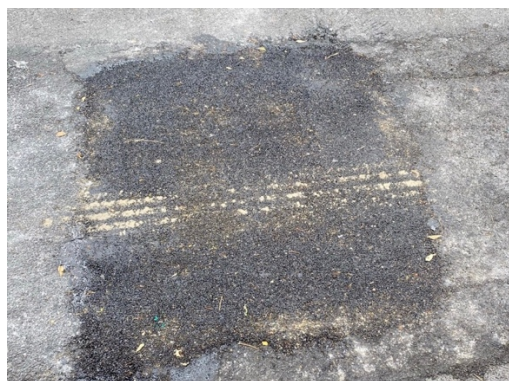
รูปที่ 2.1 ความเสียหายประเภทรอยปะซ่อม (บริเวณหน้าอาคารจามจุรี 9)
