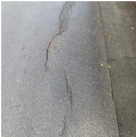
รูปที่ 2.2 ความเสียหายประเภทรอยแตกกร้าว (บริเวณข้างสนามสนามกีฬาจุฬาลงกรณ์)
